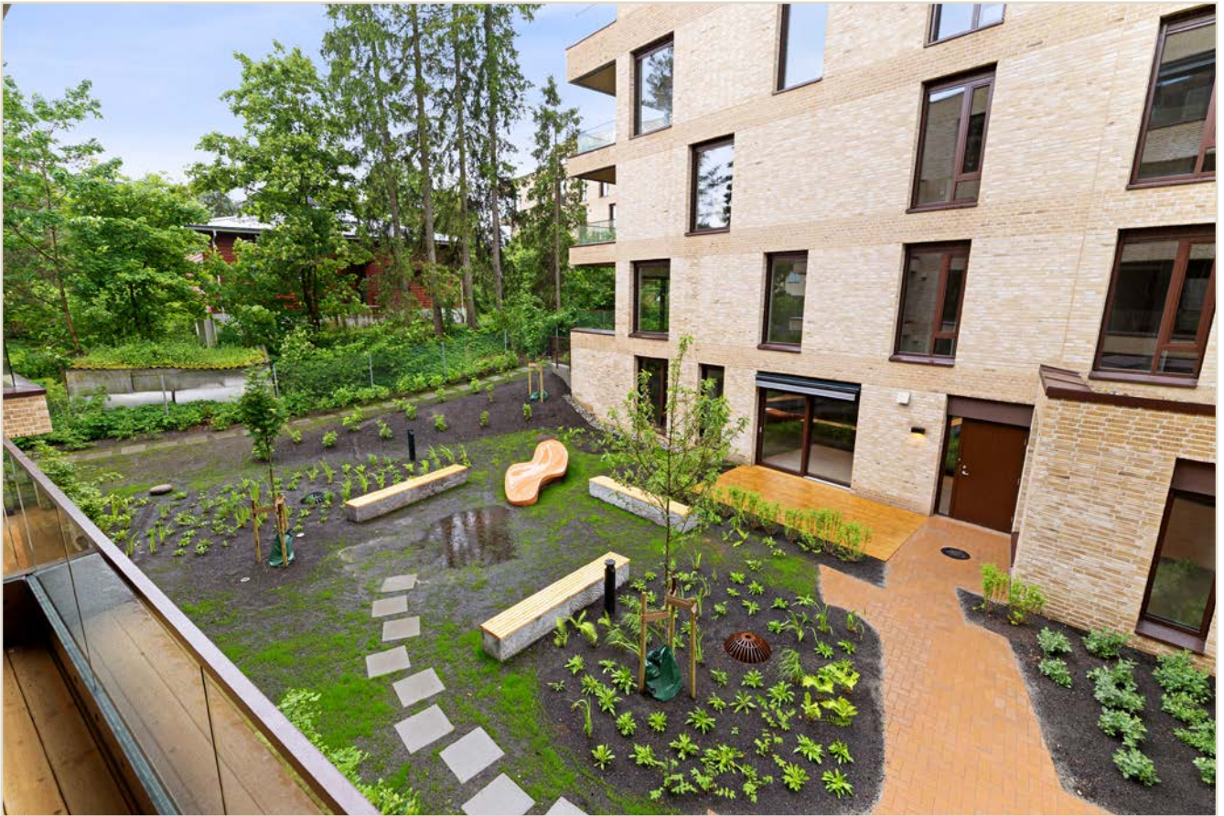
Utsikt mot fellesarealene som er opparbeidet med grønne soner, sittebenker og lekeapparater.
