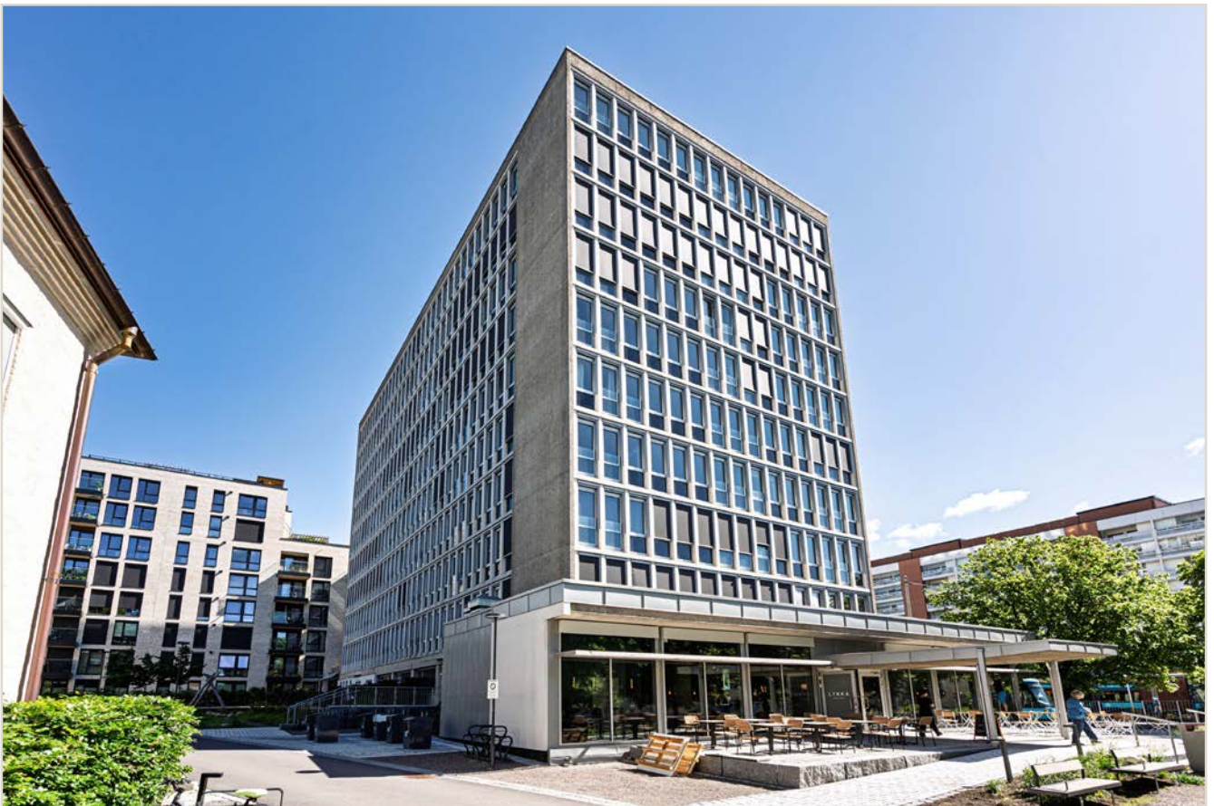
Leiligheten er en del av Torshovhøyden Eierseksjonssameie som består av 146 seksjoner, hvorav tre er næringsseksjoner. Bygget ble bygget om fra næring til bolig i 2024 (opprinnelig oppført i 1902).
