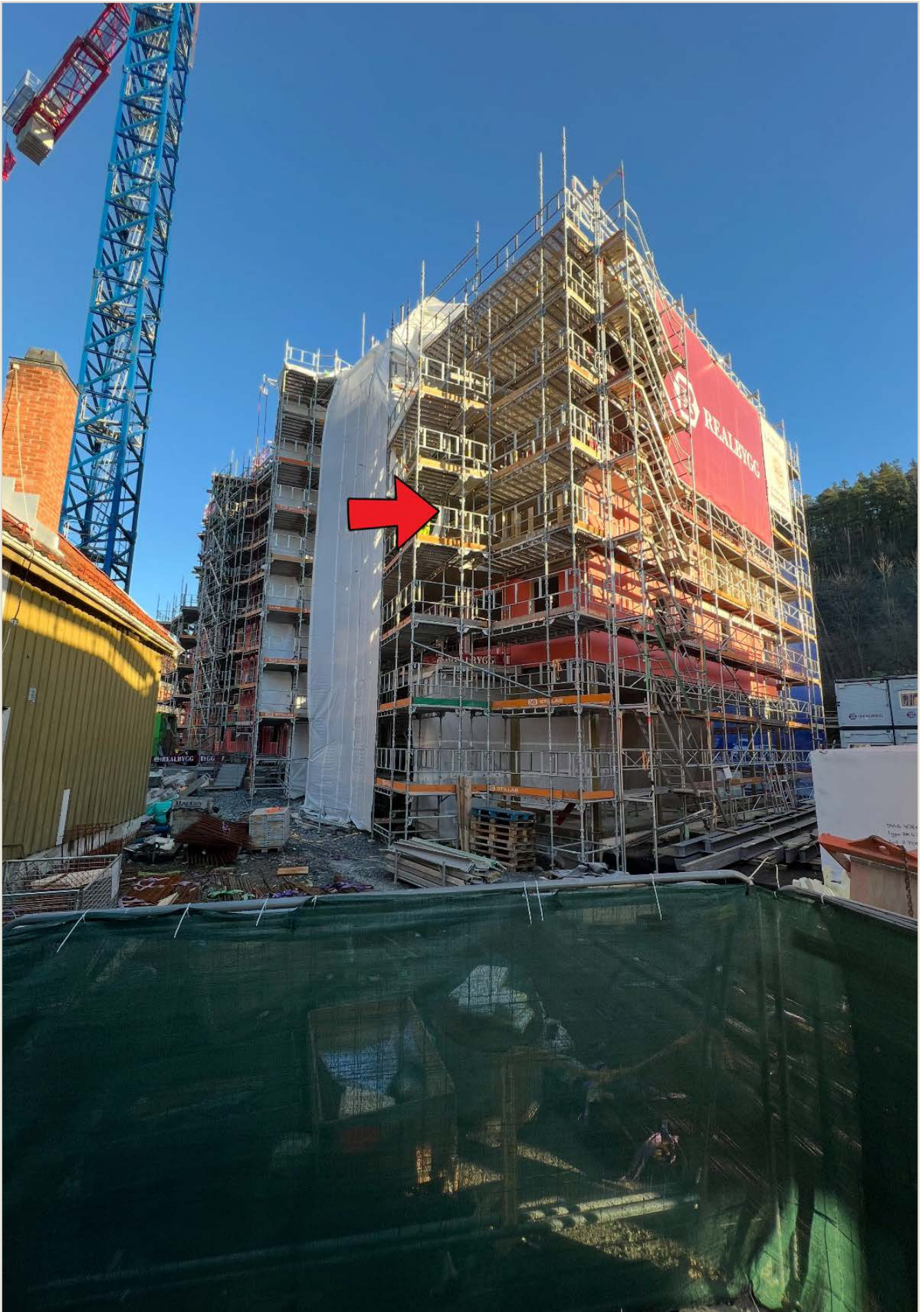
Bilde fra byggeplass.
