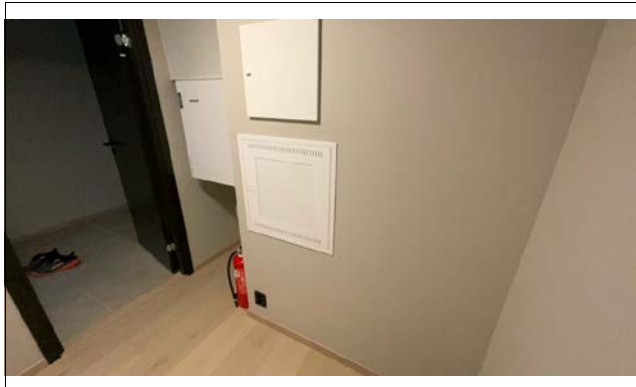
Ikke målbart BRA under ventilasjonsanlegget
