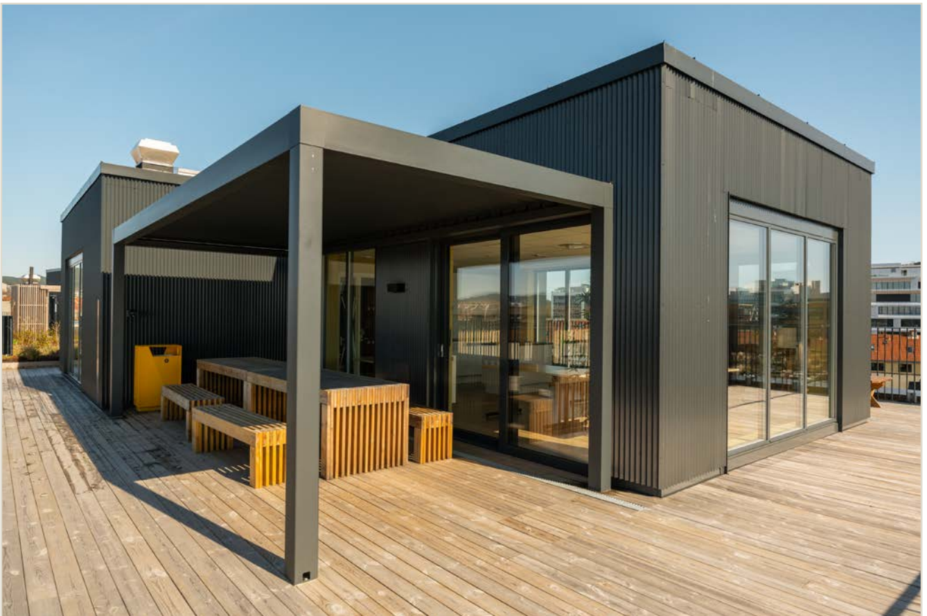
Det er en felles takterrasse med sol hele dagen som beboerne har tilgang til.
