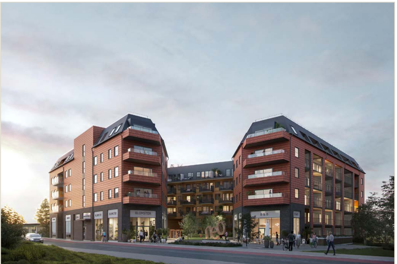
Illustrasjon | Prosjektet Neo ligger sentralt til ved Ås stasjon. Byggene blir formet som en hestesko med en trivelig bakgård med gress, benker, planter, trær og lekeapparater. Avvik kan forekomme.
